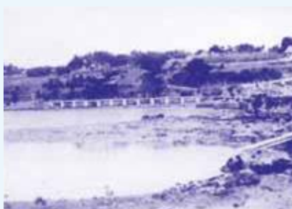
▲那覇市へのびる水道管 (宇地泊の河口付近)
