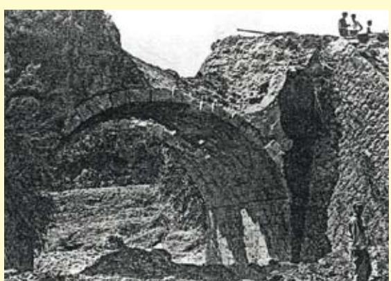
1945(昭和20)年 日本軍に爆破された時の普天間橋
