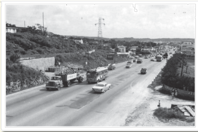
▲大山の給油所近くから真志喜を望む 1964 (昭和 39) 年 写真右側の空き地奥が給油所で、左側にはガスボンベらしきものあり、この擁壁は現在も見られます。
