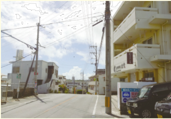
▲どこにでもある住宅地を抜ける道路、この先が急な坂道になっています。
