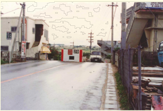
▲パイプラインに付属するバルブボックス1991(平成3)年パイプラインは、喜友名と伊佐の堺付近で合流し、軍用1号線に沿いに浦添・那覇を通っていました。
