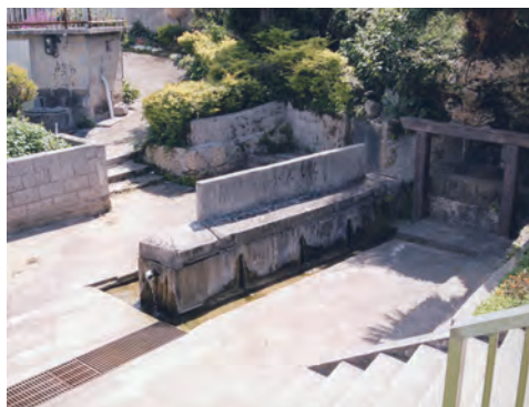
▲クンチンガーとも呼ばれ、水の湧き水によって「イモ、ヤサイ、洗場」「浴場男川」にわかれています。1953(昭和28)年に改修工事が行われました。
