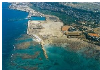
▲市立体育館と沖縄コンベンションセンター建築前の埋め立て後の様子 1985年（真志喜・宇地泊沖）
