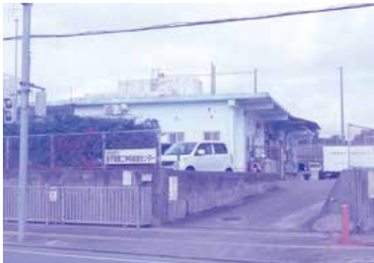
平成29年度に取り壊し予定の普天間第二学校給食センター
