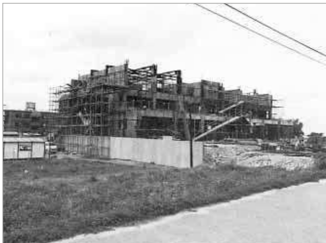
昭和53年ごろ キャンプマーシー跡地に 建設中の普天間警察署
