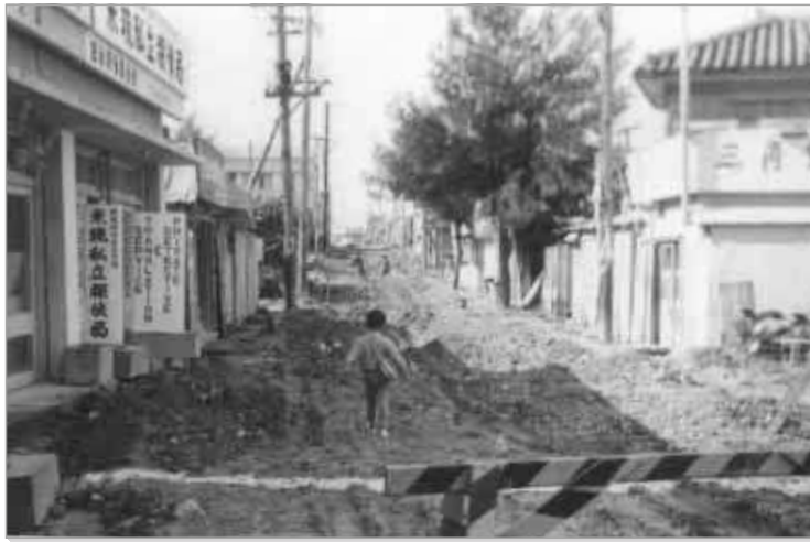
1966年(昭和41年) 郵便局通りの道路舗装工事
