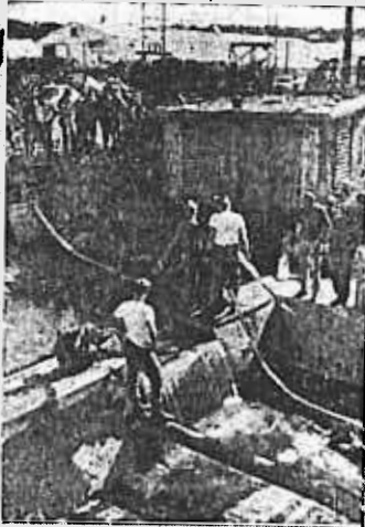
排水溝に流出した油をポンプで吸いあげ、作業に当たった宜野湾消防署員と米兵たち（宜野湾市伊佐で）
