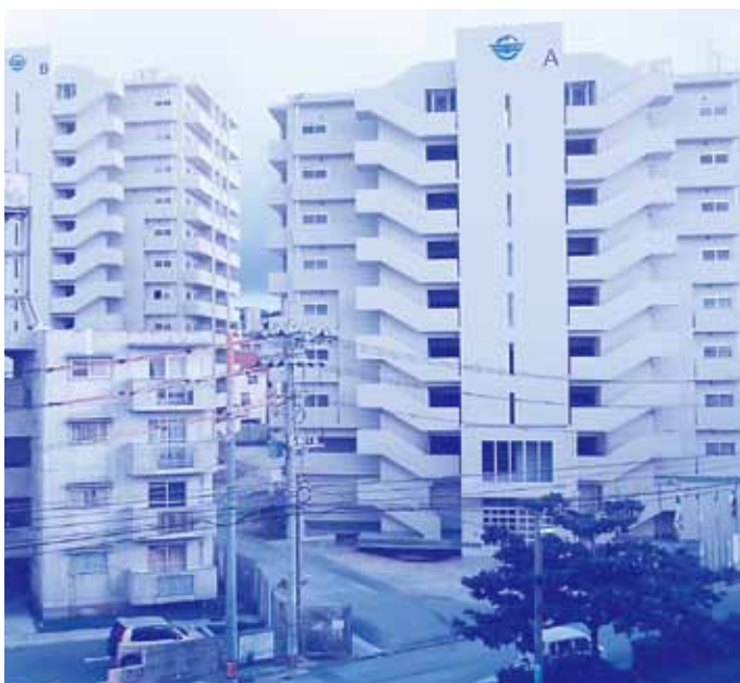
着々と建設が進む伊原市営住宅
