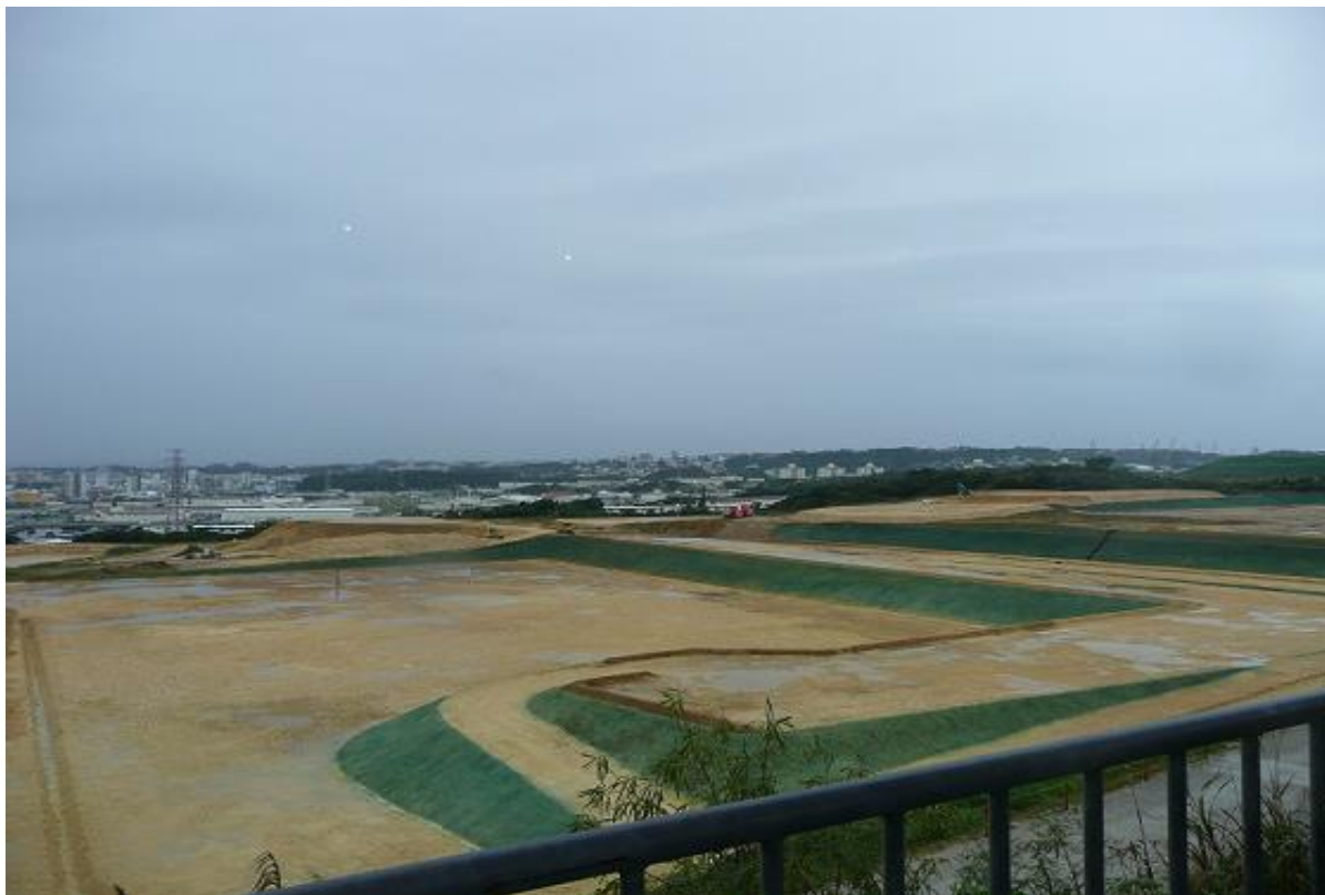
視察時の西普天間住宅地区の様子
