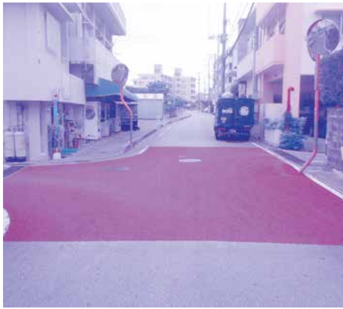
カラー舗装がされた市道宜野湾6号及び7号の交差点
