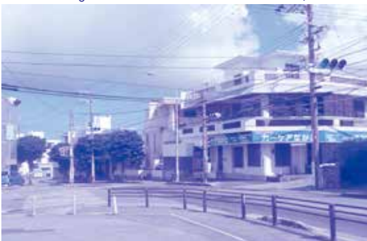
交差点改良工事が期待される市道長田1号と県道32号線との交差点
