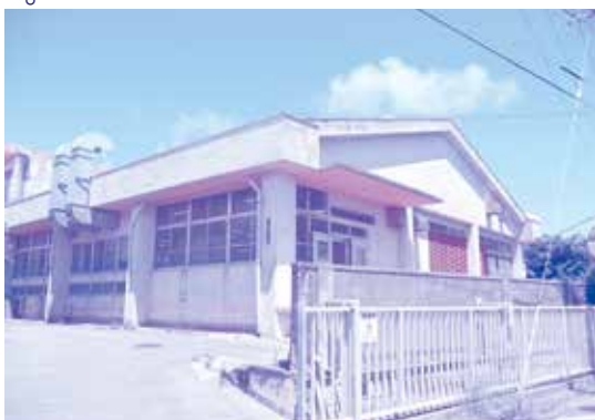
平成29年度取り壊し予定の真志喜学校給食センター
