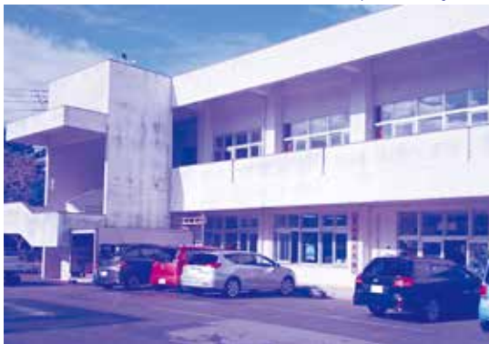
早期の改修が望まれる愛知地区学習等供用施設
