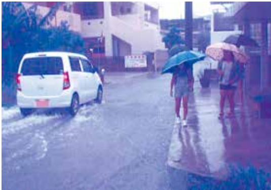
冠水対策が望まれる我如古地内の道路
