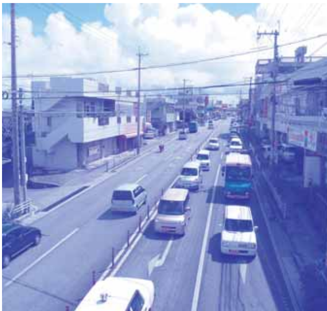
拡幅工事が計画されている国道 330 号 (我如古交差点より)
