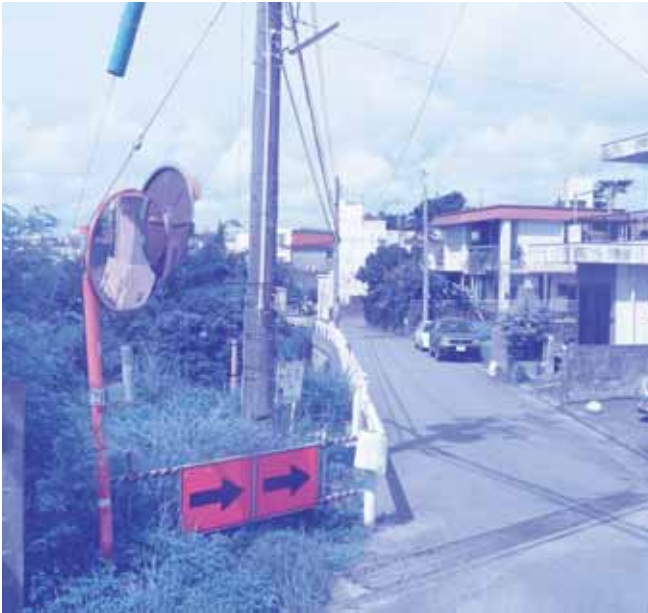
平成24年度から下水道整備が予定されている中原ハンタ道付近
