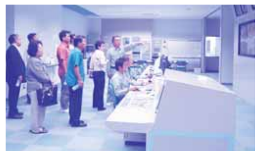
倉浜衛生施設の中央制御室で担当より説明を受ける
