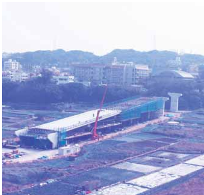
着々と工事が進む市道大山7号の架橋建設工事
