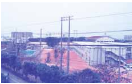
増改築のため旧校舎が取り壊し工事が進む
