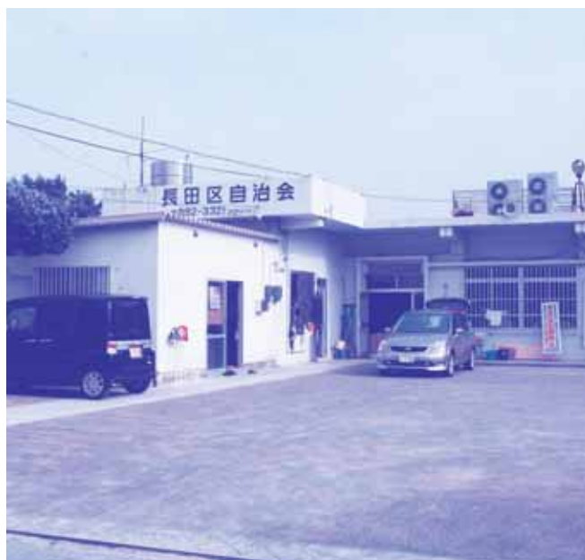
老朽化、狭隘なため、区民からも新施設の建設が期待される
