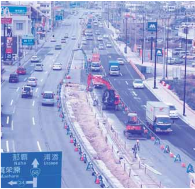
中央分離帯の閉鎖が問題になっているマリーナ通り線との連結箇所
