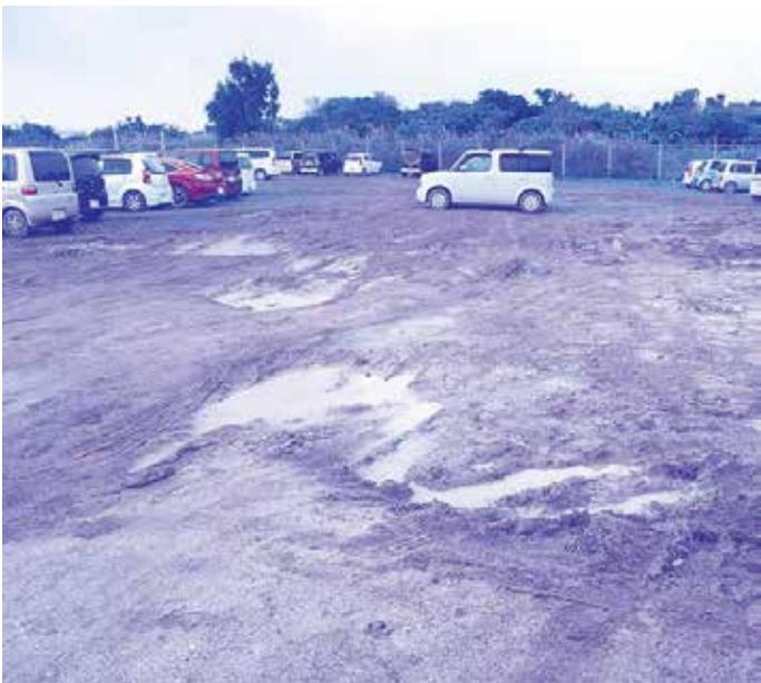
地面の凹凸により車両の破損が懸念される市民広場駐車場
