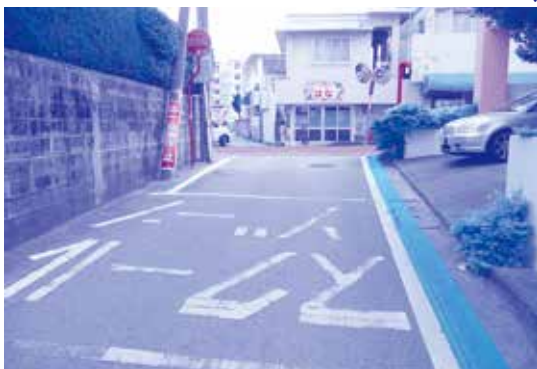
歩道にカラー舗装がされた市道宜野湾6号
