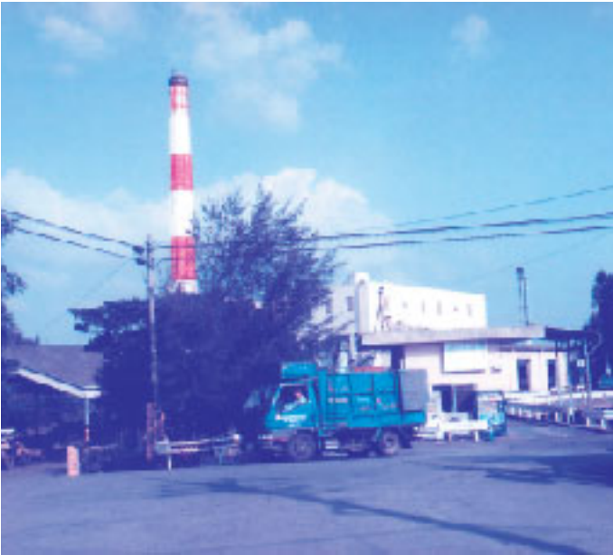
倉浜衛生施設組合(沖縄市)
