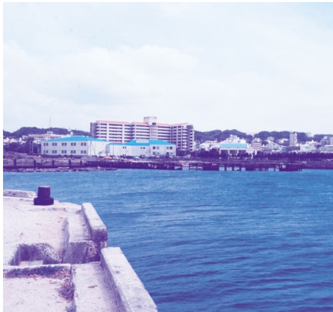
基本計画が策定されたものの、手つかずの状態にある仮設避難港
