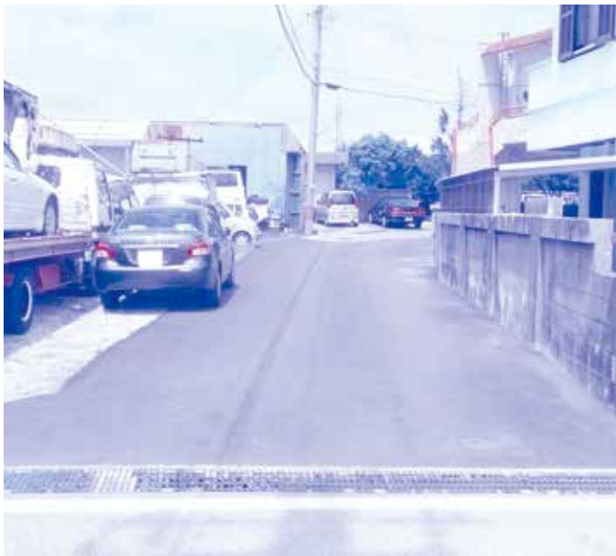
舗装後も側溝整備の要望がある愛善保育園への進入路
