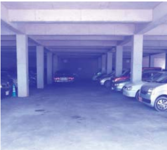
きれいに整備がされた体育館下の状況
