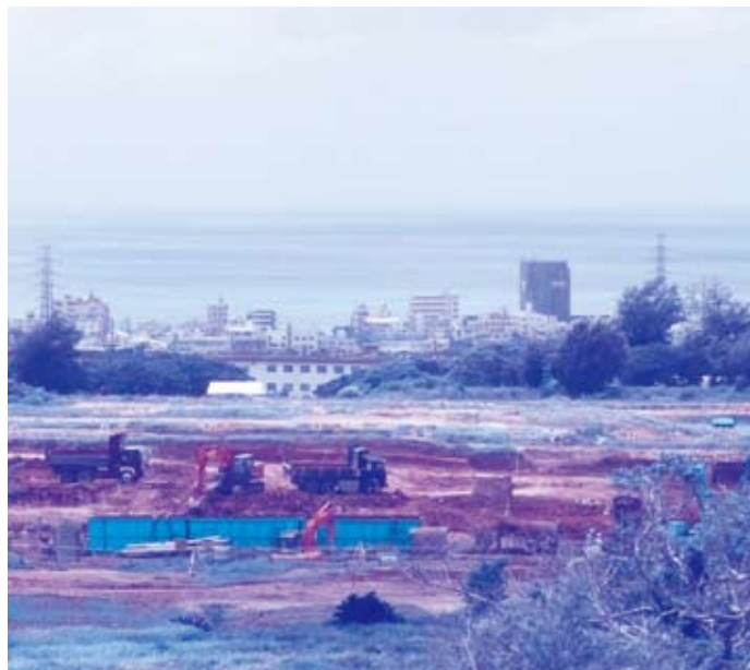
海軍病院建設現場(キャンプ瑞慶覧内)
