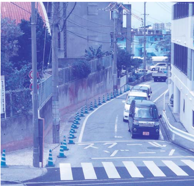
安全確保のために花壇が撤去された宜野湾小学校横の市道
