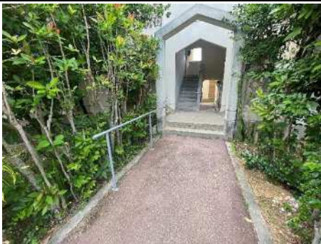
▲F号棟へのアプローチ部分 F号棟へのアプローチ部分にスロープは整備されていないが、手摺は設置されている。
