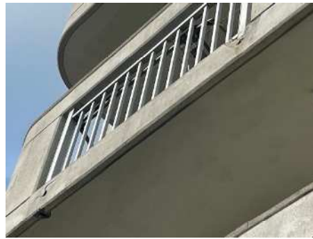
▲F号棟手摺支柱基礎爆裂あり
