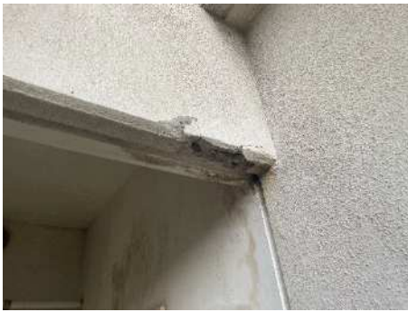
▲G号棟コンクリート爆裂あり G号棟では、供用階段の垂れ壁や玄関バルコニーの手摺支柱基礎部分にコンクリートの爆裂がみられる。
