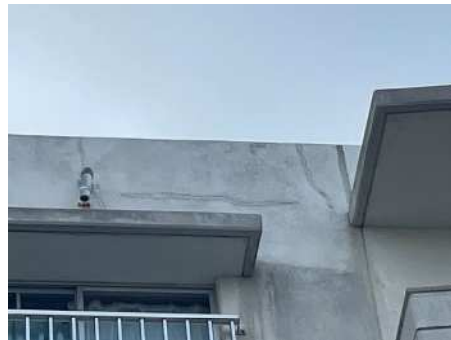
▲G号棟外壁 部分的に補修が行われている。
