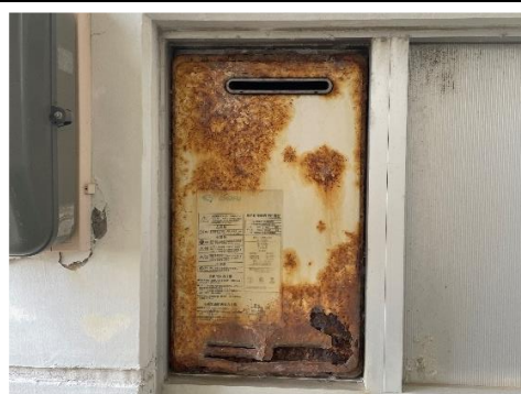
▲G号棟ガス給湯器設備 ガス給湯設備に錆がみられる。
