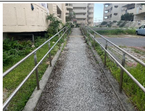
▲スロープおよび手摺設置状況（3号棟）
