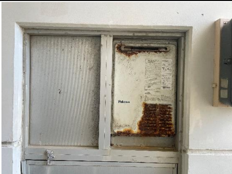
▲F号棟ガス給湯器設備 ガス給湯設備に錆がみられる。
