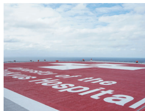
屋上ヘリポート
